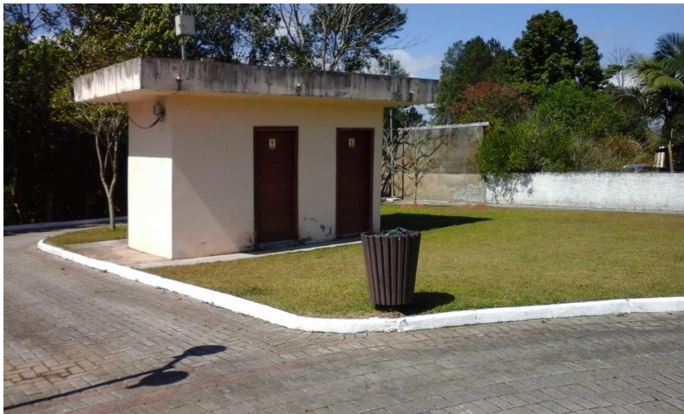
Imagem 05: Situação atual da praça – sanitários.
