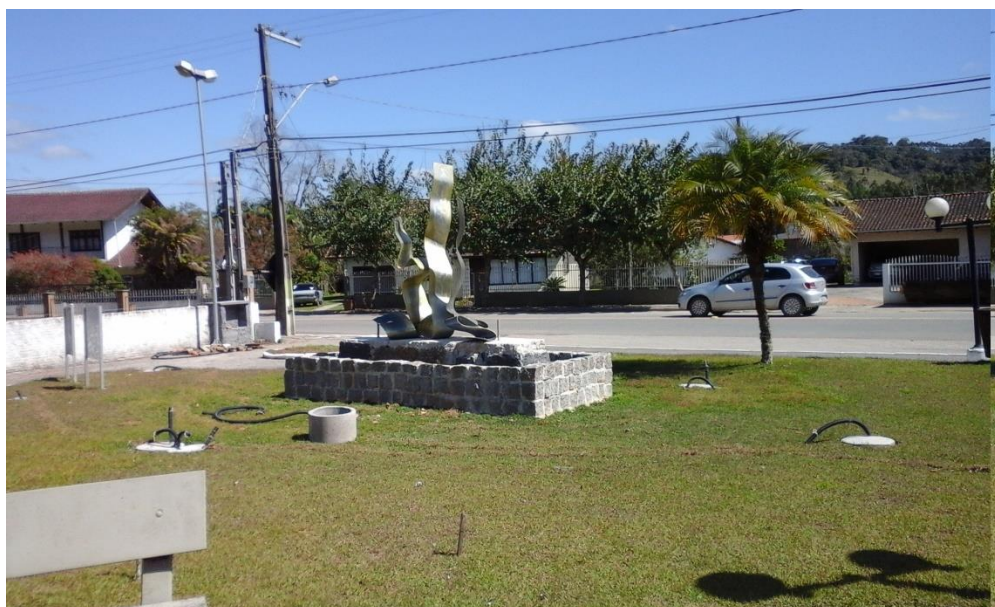
Imagem 06: Situação atual da praça –chafariz.
