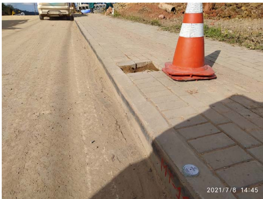
Figura 4.3 - Trecho com pavimento existente (Rua Lurdes).
