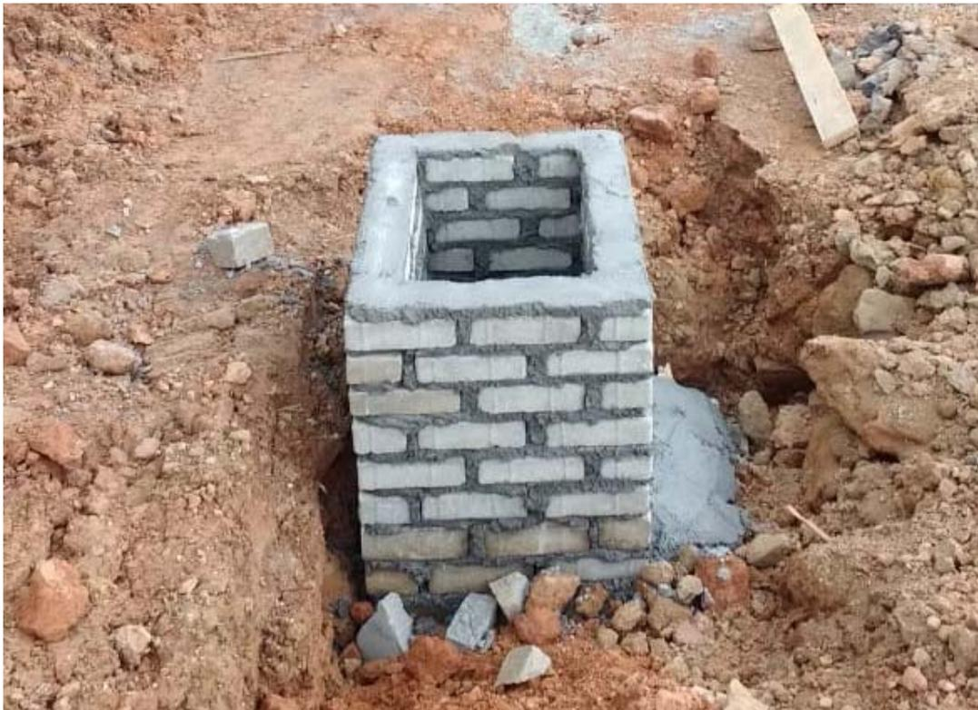
**Figura 7.2** - Caixa de boca de lobo existente.
