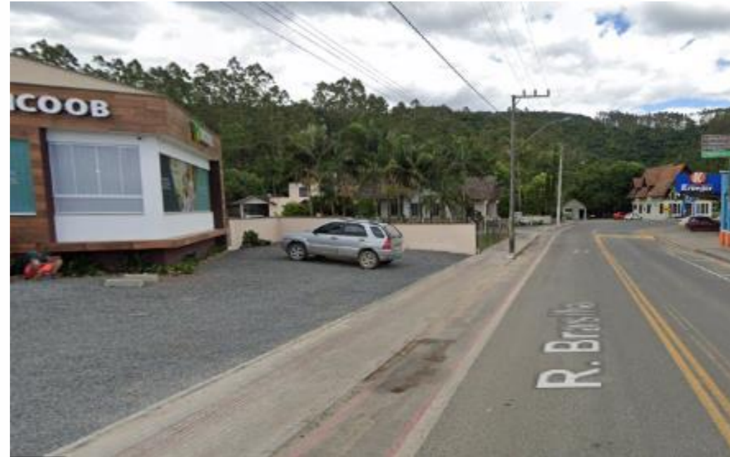
Figura 156 – Ponto Crítico 3, interseção da SC - 477 (Rua Brasília)
