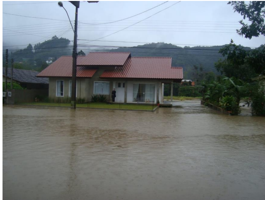
Figura 25 – Alagamento na Rua Aderbal Ramos da Silva em 2014
